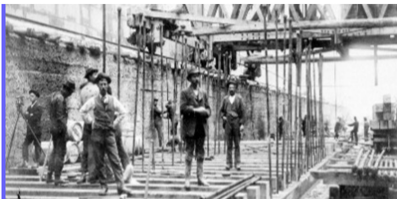
Construction du canal de Sault Ste. Marie, novembre 1893.
